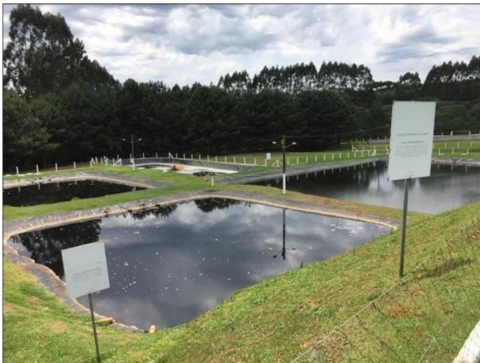
Figura 61. Estação de tratamento de chorume. Fonte: PMIGRS, 2019.
