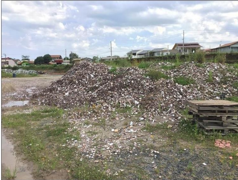
Figura 72. Pátio da Sec. de Infraestrutura (disposição de RCC). Fonte: PMIGRS, 2019.
