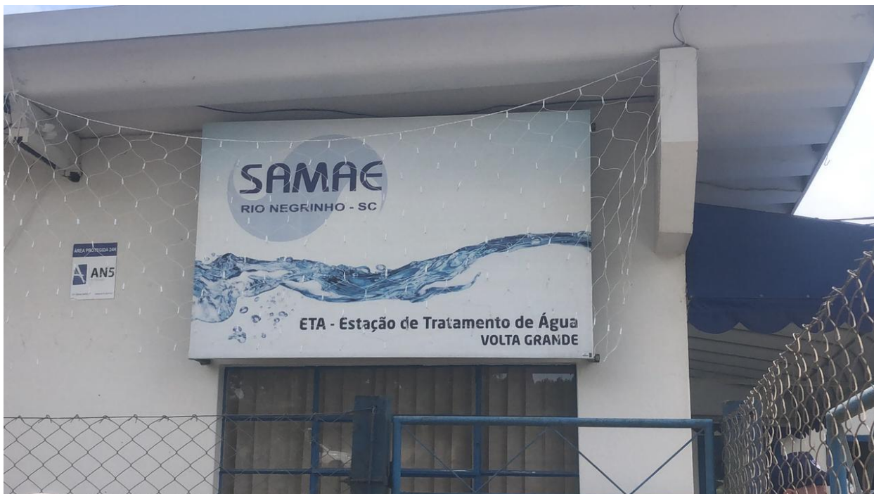
Figura 34. Estação de Tratamento de Água Volta Grande.
