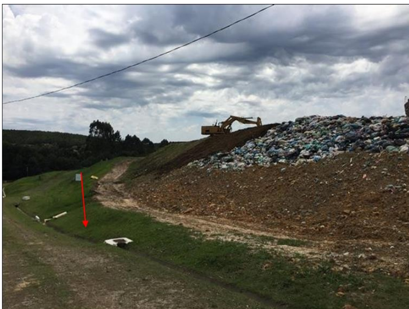
Figura 69. Aterro sanit rio municipal (dreno de  guas pluviais). Fonte: PMIGRS, 2019.
