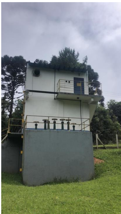
Figura 32. Casa de bombas – Captação no Rio Negrinho.
