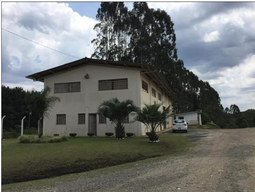
Figura 68. Aterro sanit rio municipal (edifica o de apoio). Fonte: PMIGRS, 2019.
