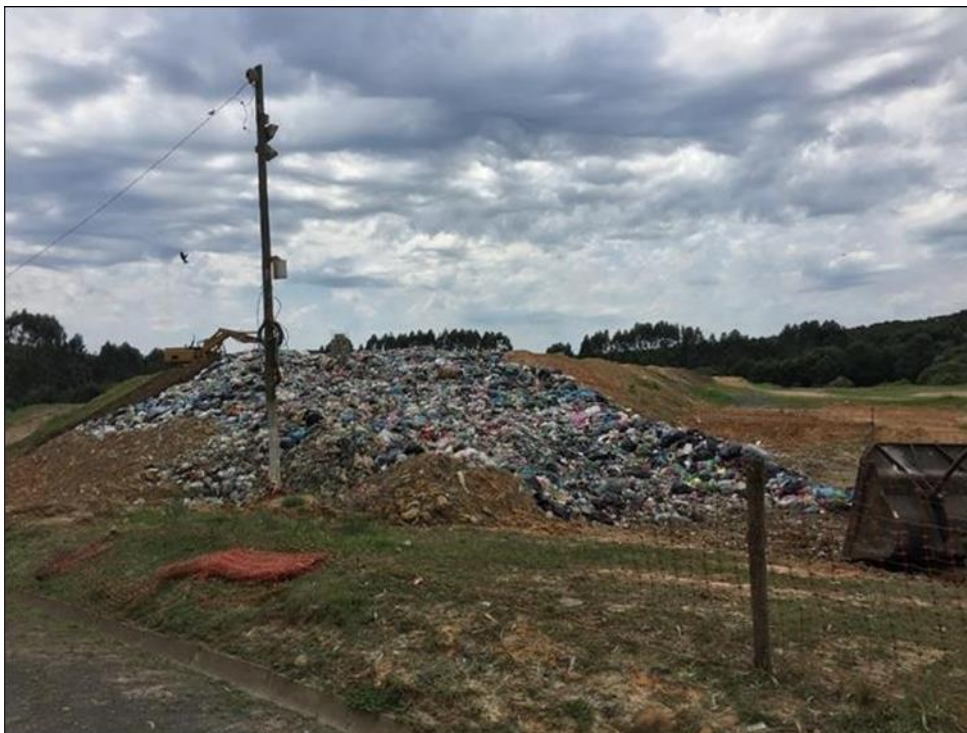
Figura 60. Atual frente de serviço do aterro sanitário municipal. Fonte: PMIGRS, 2019.
