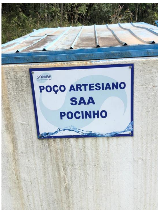
Figura 39. Poço Artesiano – SAA Pocinho – Vista Externa
