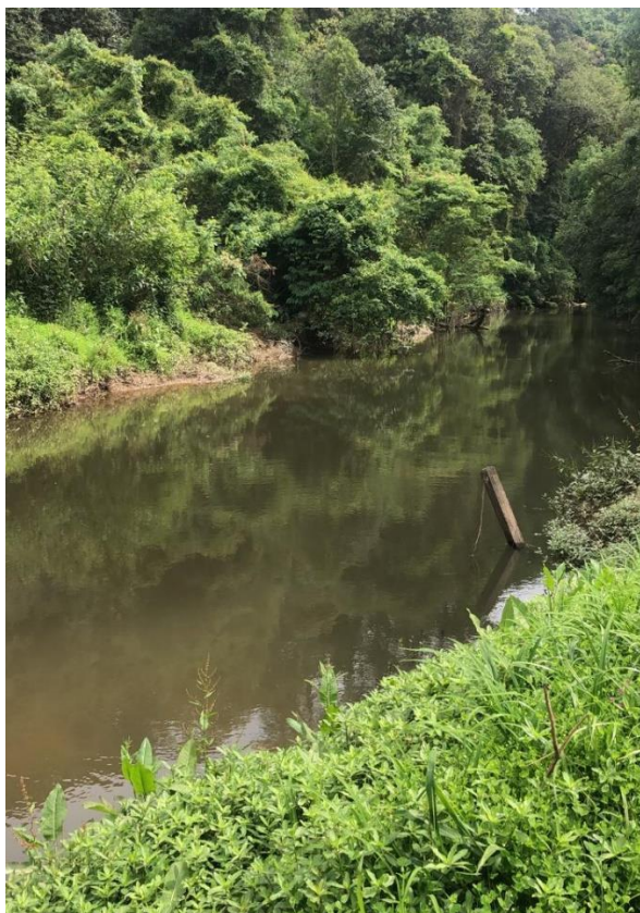
Figura 31. Captação superficial no Rio Negrinho.
