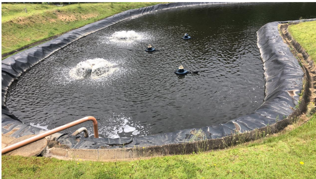
Figura 42. Lagoa aerada facultativa da ETE São Pedro.
